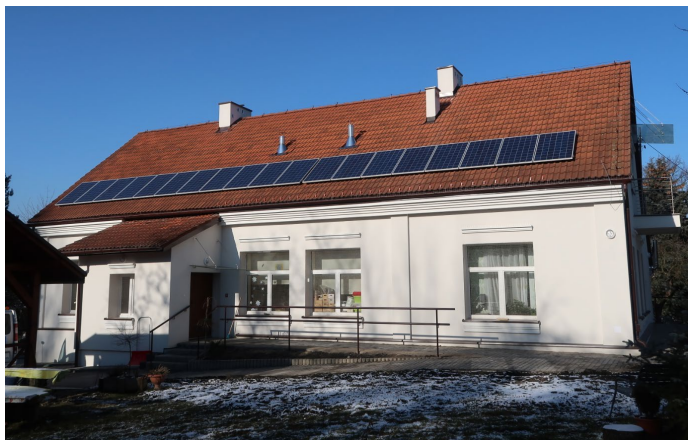
MOPS przy ulicy Cechowej
